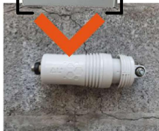
Placez les boulons de blocage, utilisez du freinfillet pour vous assurer de la bonne tenue dans le temps, assurez-vous que le capteur est stable et bien positionné. Faire attention a ce que le logo du capteur soit dos au mur et face a vous.
