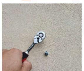
Placer l'équerre là où vous voulez le positionner pour marquer les zones et percer au diamètre 6 ou 7 pour placer les goujons M6 frapper les à fleur avec un boulon puis serrer avec une clé à clique de 10 pour faire ressortir la tige de 2 cm puis retirer le boulon.
